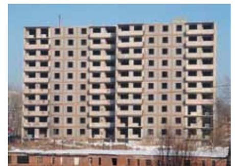
фундамент свайный ростверк, железобетонный монолит, стены наружные – трехслойные панели, внутренние – однослойные панели, перекрытия: чердачные, междуэтажные, подвальные – сборные железобетонные; кровля – совмещенная рулонная.
