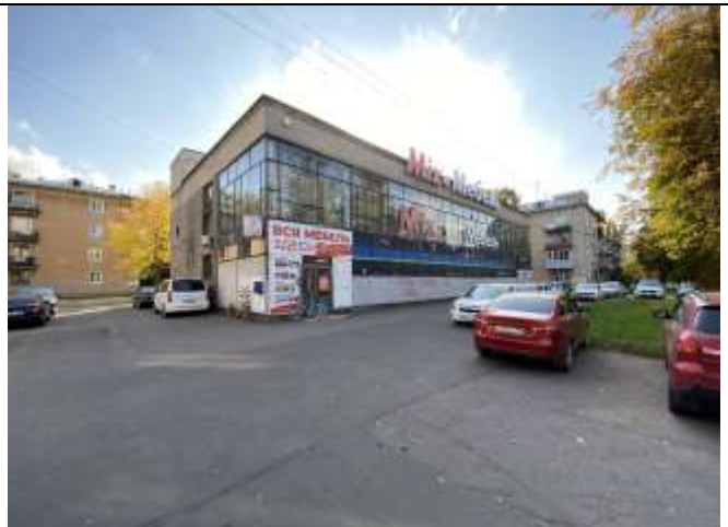
Фото №6. Нежилое здание, в котором располагается Объект оценки
