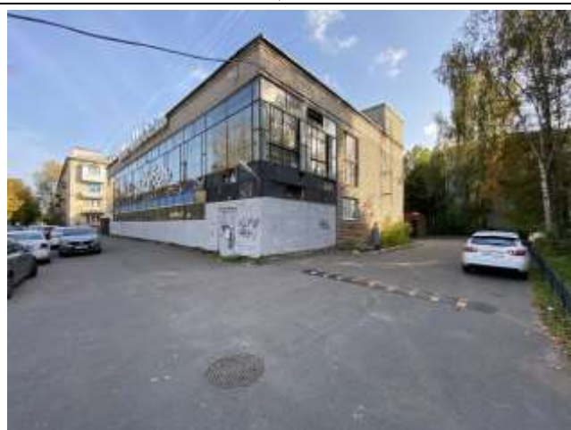
Фото №5 Нежилое здание, в котором располагается Объект оценки
