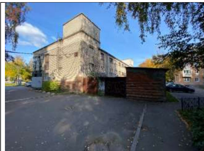
Фото №3 Нежилое здание, в котором располагается Объект оценки
