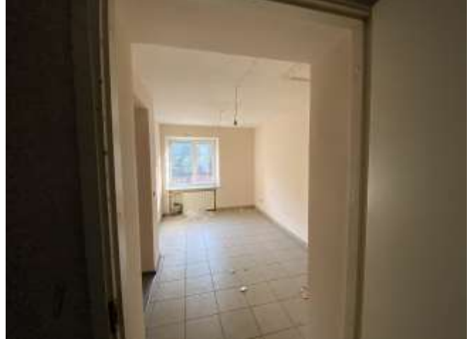
Фото №18 Входы в помещение
