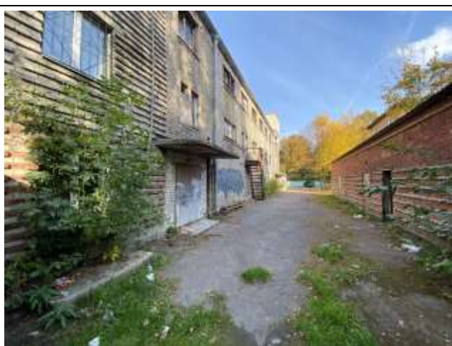
Фото №1 Нежилое здание, в котором располагается Объект оценки
